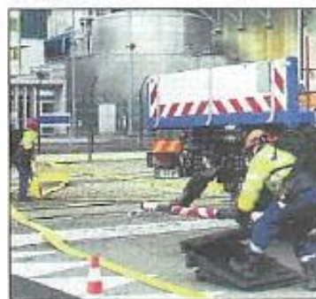
Installation des tuyaux d'alimentation en eau par les techniciens de la FARN
